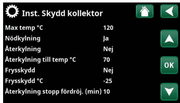
Meny "Avancerat/Inställningar/Solpaneler/Skydd kollektor.
